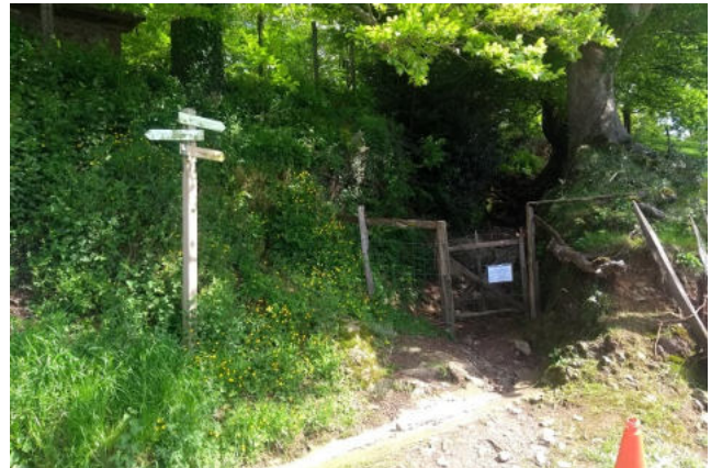
Portón para abandonar pista asfaltada
